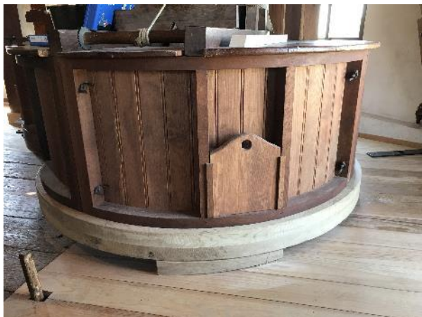
Instandsetzungsarbeiten am Windmahlgang der Götzberger Windmühle
