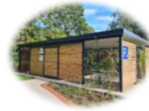
Fahrradunterstand mit Gründach und PV-Anlage
