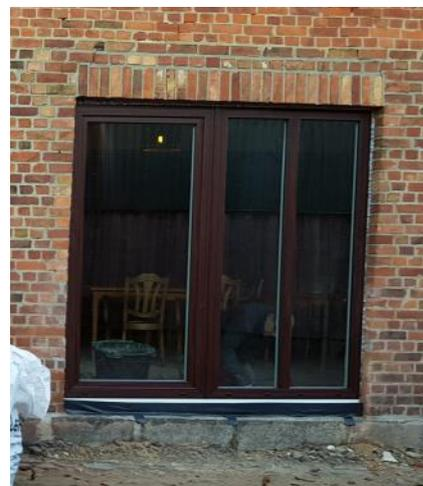
Im Zuge des Projektes wurden die maroden, einfachverglaste Fenster des „Juhls Gasthof“ in Itzstedt gegen bodentiefe Kunststofffenster mit Isolierglas ausgetauscht. Der Bereich des Saales der Gaststätte wird so nicht nur lichtdurchflutet
